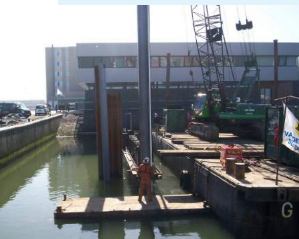
Duikbassin in aanbouw
