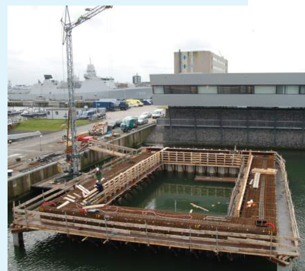
Heiwerk tbv bouw duikbassin
