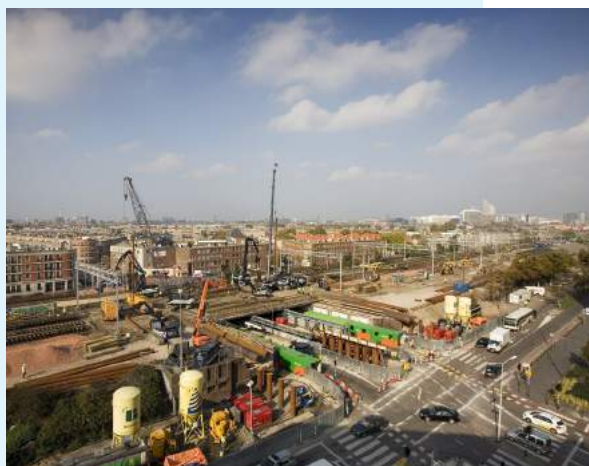
1e stap aanbrengen damwanden en palen in spoorwanden.
